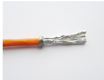
Prepare the shielding Vorbereiten der Kabelabschirmung Préparer le blindage des câbles
